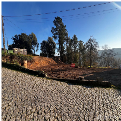
Terreno de construção Freixo de Cima
